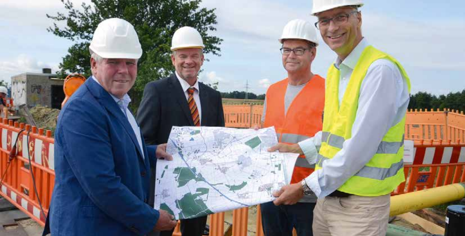
Vor der Baugrube des Schieberkreuzes in der Feldmark: Sehndes Bürgermeister Carl Jürgen Lehrke (von links), EVS-Geschäftsführer Frank Jankowski-Zumbrink, Dieter Fochler von der Avacon und EVS-Geschäftsführer Torsten Ahl.
