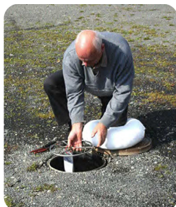
Unter leichtem drehen am Grifftrad wird die Zähleranlage wieder abgesenkt.
