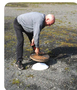
Nicht vergessen, das Isoliertkissen einzulegen, bevor der Deckel geschlossen wird.
