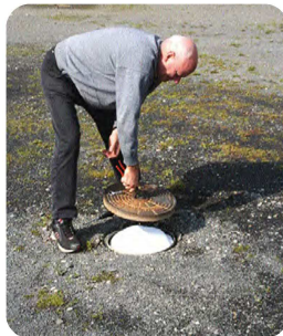
Nach Entfernen von Deckel und Isolierverschluss wird die Zähleranlage unter leichtem Drehen herausgezogen.
